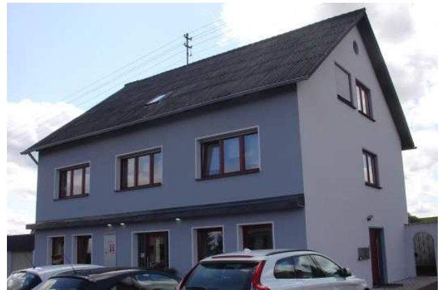
Strassenansicht des Gebäudes – energetisch sanierte Außenfassade mit neuen Eingangstüren und neuen Fenstern, © Saar-Lor-Lux Umweltzentrum GmbH
