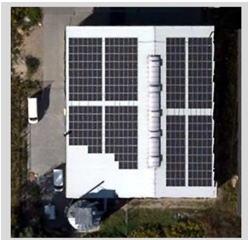
Photovoltaikanlage – Dachbereich © Handwerkskammer zu Leipzig
