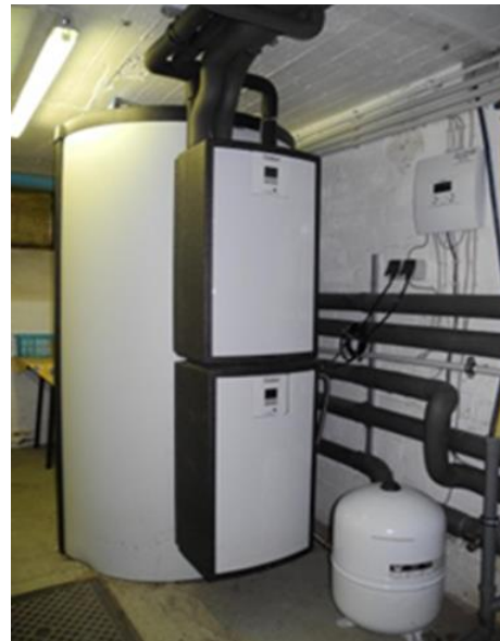
900 Liter Solarspeicher gewährleistet hauptsächlich regenerative Warmwasserversorgung; © Handwerkskammer Münster
