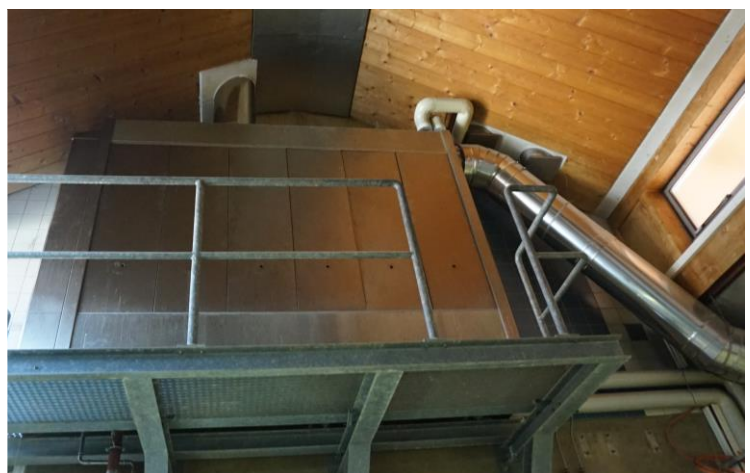
Die Rauchgaswaschanlage der Bäckerei reduziert auch den CO 2 -Ausstoß der Abgase © Dirk Bräu, Handwerkskammer für München und Oberbayern
