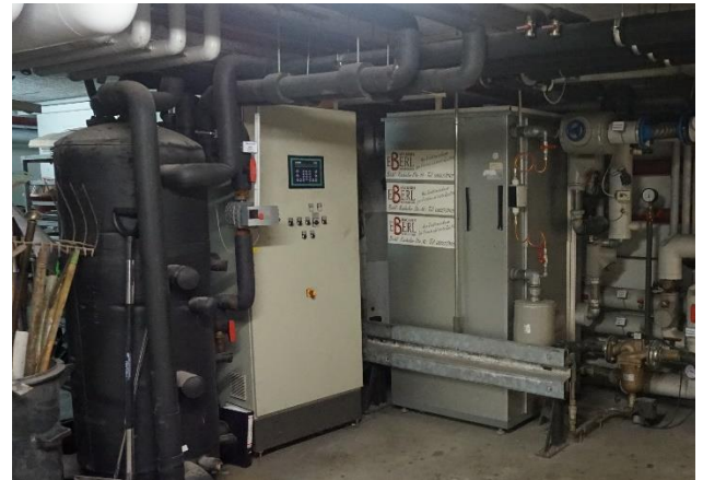
Ein Blick auf die Absorptionskälteanlage © Dirk Bräu, Handwerkskammer für München und Oberbayern
