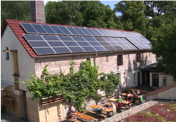
Backstube mit PV und Solarthermie sowie Hofcafe © VKU Verband kommunaler Unternehmen e.V.
